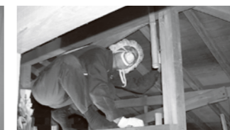
小屋裏の調査
