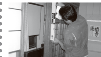
建物の倒れ確認
