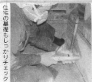
住家の基礎もしっかりチェック
