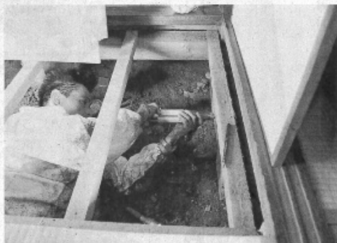
床下に入って基礎部分の強度を測る耐震診断の調査員
